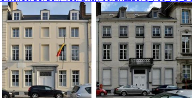
Figure 19 : façades avant, n°23 et 21 (CRMS ; 2018)
