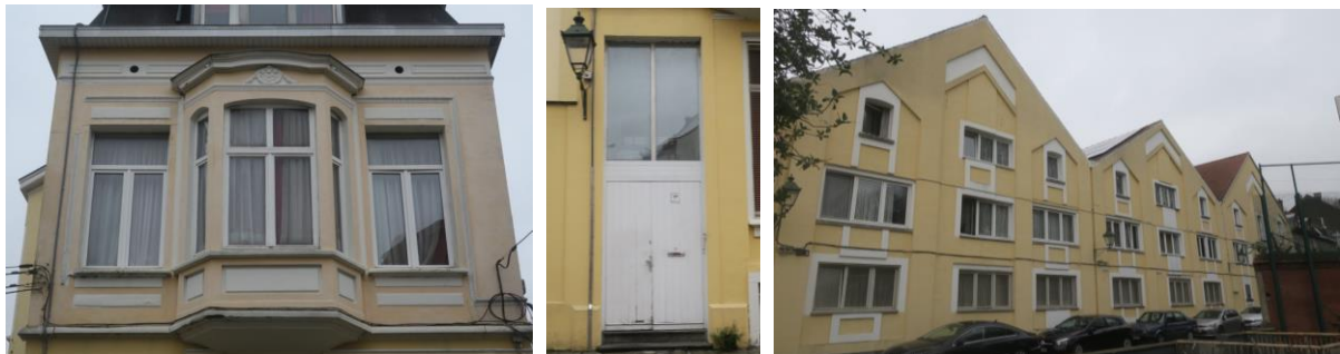
Gevel aan de kant van de Paleizenstraat over de Bruggen, met de erker en de ingang, zichtbaar vanaf het beschermde gebouw.
