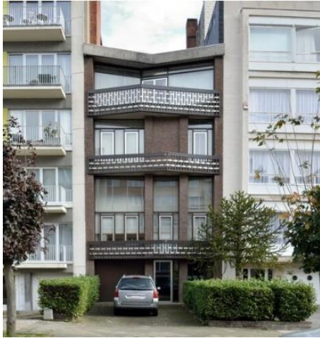
Gevelopstand aan de straatkant. Foto © urban.brussels 2024
