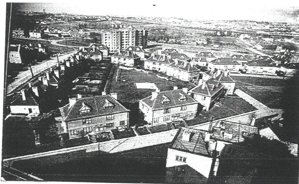
Photographie montrant l'immeuble en construction depuis le site des cités-jardins classées (vers 1930)
