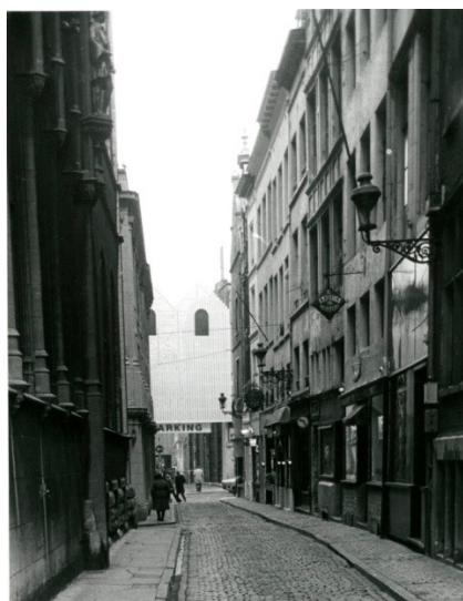
4. Rue des Harengs – environ 1980 photo CRMS
