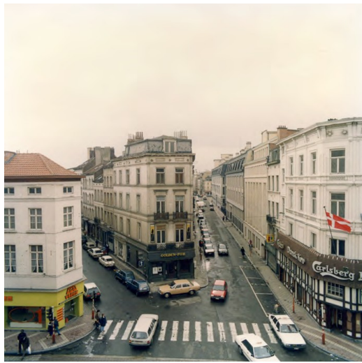
Immeuble d'angle donnant sur la chaussée d'Ixelles, démoli en 1987
