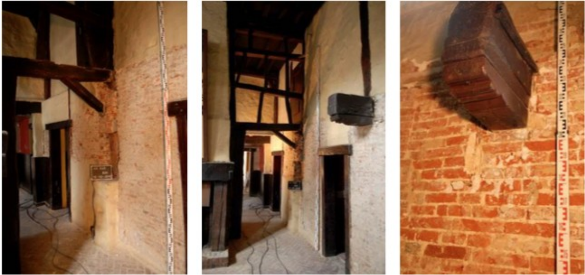
L'espace du rez-de-chaussée. UC040_0229, UC040_0228, UC040_0236. Photos, S. Modrie © SPRB.
