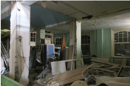
Rez-de-chaussée avec châssis à guillotine
