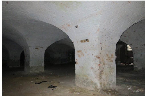
Sous-sol avec voûtes de briques
