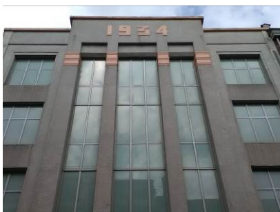
Rue des Commerçants 67 (bien classé dont la zone de protection inclut l'immeuble 48-50)
