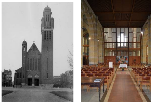
L'église de la Ste-Famille fut réalisée en deux phases, la seconde dans les années '30, avec un clocher d'une facture plus contemporaine que celle prévue initialement. (Collection privée et IRPA)
