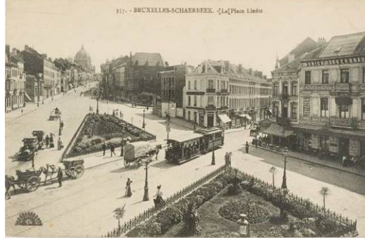
Perspective encombrée par les ouvrages de la Jonction Google Street View Gallait)
