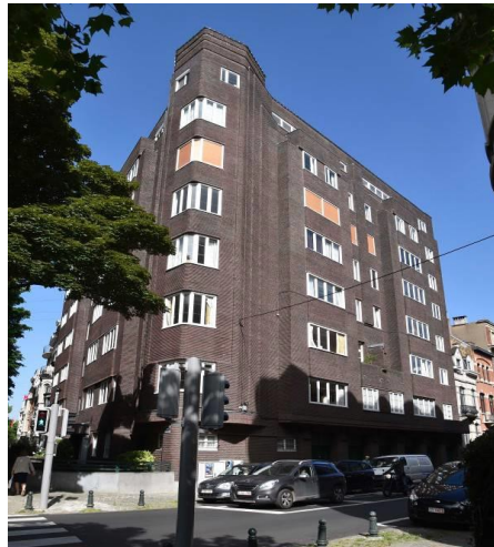
Figure 1 : Vue des façades extérieures de l'immeuble (APEB, « Immeuble à appartements Avenue Molière 210 à Ixelles, Etude historique et matérielle des parties communes », Volume II : illustrations, p. 24, juin 2017)
