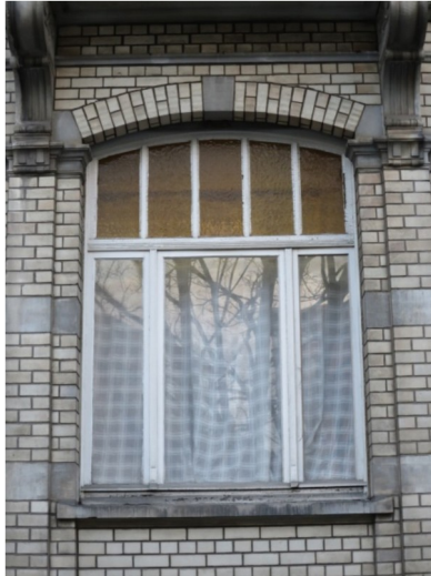
Châssis du rez-de-chaussée du n° 11 square A. Steurs
