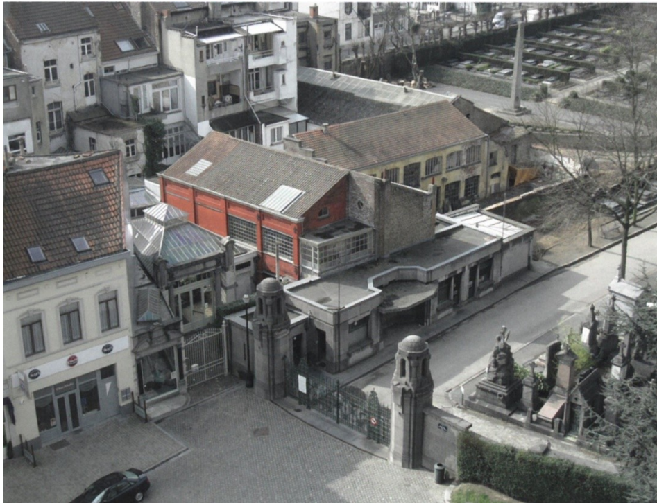
Fig. 3. Vue aérienne de l'ancien atelier Salu. Cliché T. Verhofstadt, 2014. © asbl Epitaaf.
