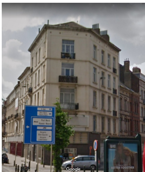
Fig. 1. Vue sur l'ensemble des bâtiments concernés par la demande. © Google Street View, mai 2017.
