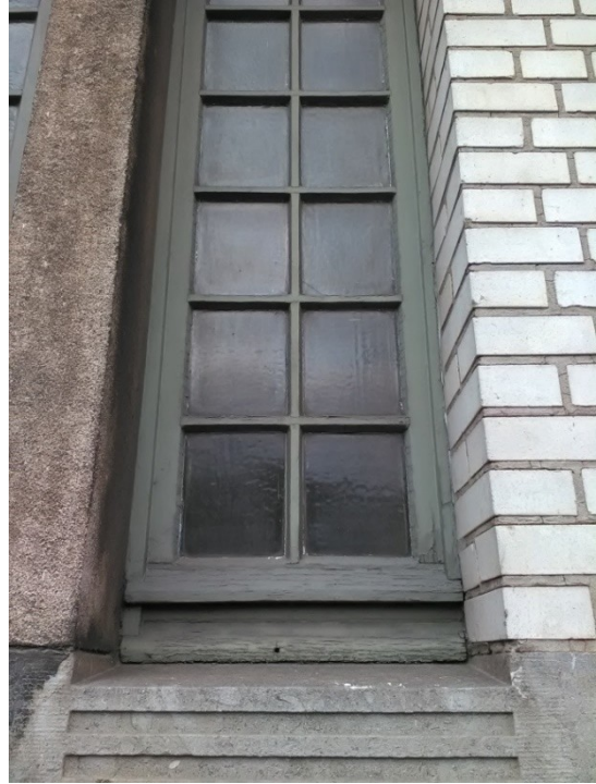
Menuiseries d'origine : porte d'entrée et un détail des anciens châssis (© CRMS-2018)
