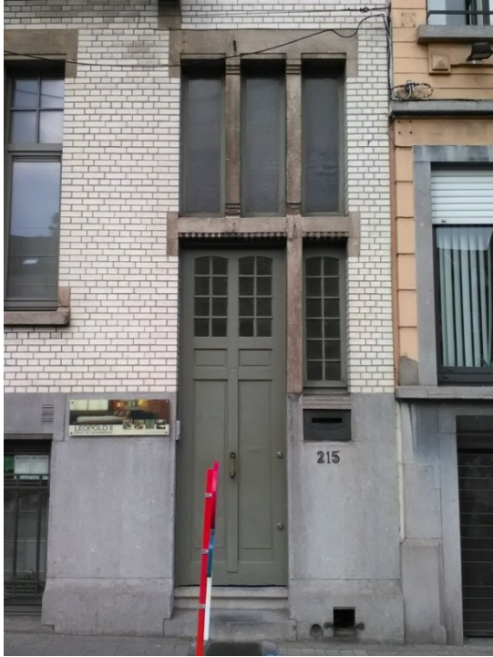
Menuiseries d'origine : porte d'entrée et un détail des anciens châssis (© CRMS-2018)
