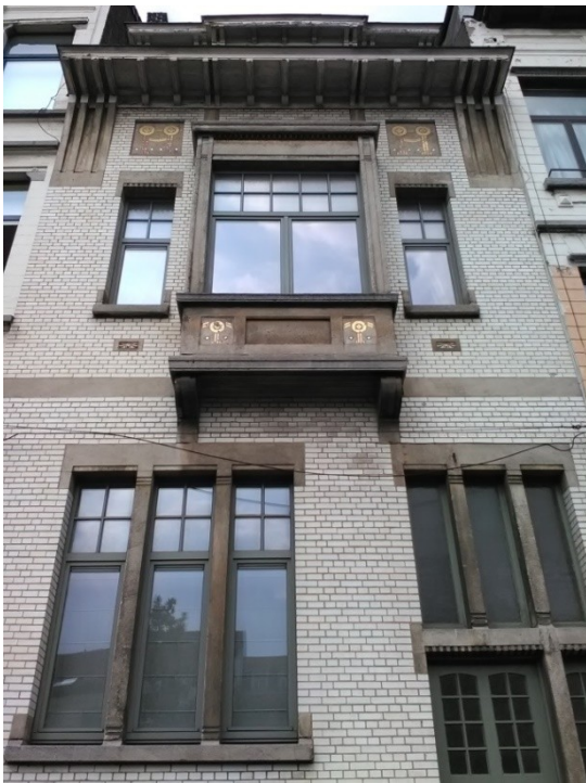
Châssis remplacés (© CRMS-2018)
