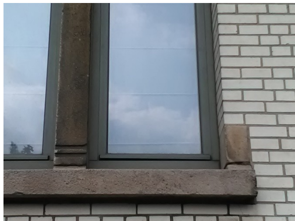
Châssis remplacés (© CRMS-2018)
