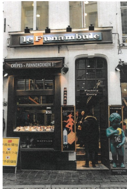
Fig. 2. Vue de la façade en 2018. © DMS
