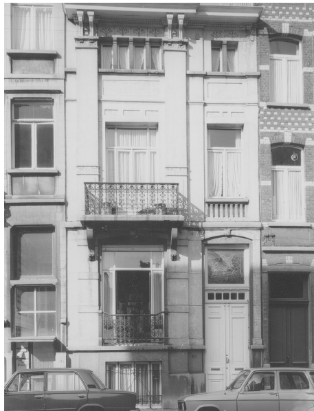
Fig. 2. Vue de la façade avant en 1980. © IRPA, cliché m16305.
