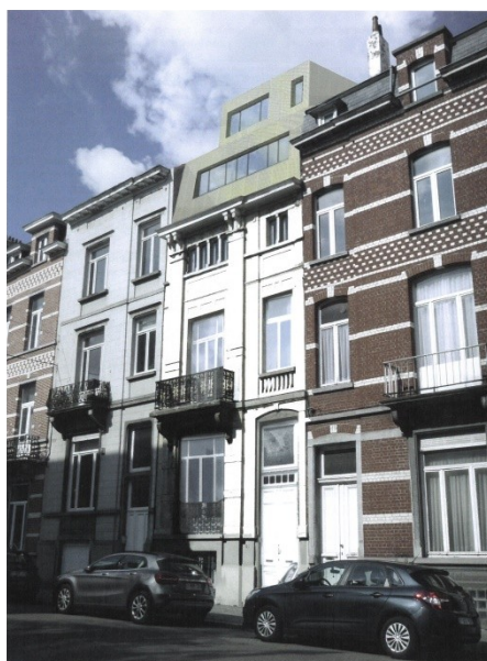
Fig. 3. Montage photo illustrant l'extension en toiture, issu du dossier de demande.
