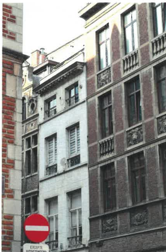
Rue du Marché au Charbon, 5 (©CRMS)
