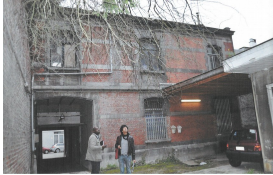
Façade arrière (archives CRMS)
