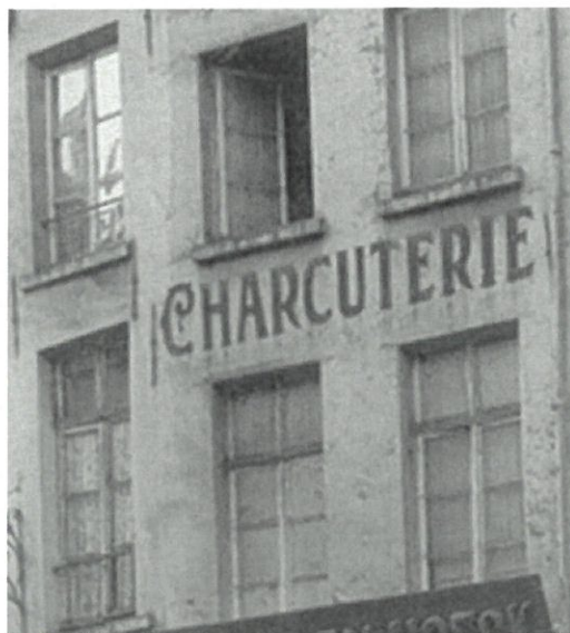
Châssis n°37, rue du Marché au Charbon
