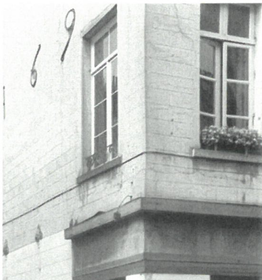
Châssis n°75, rue du Marché au Charbon
