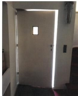
Porte d'entrée (façade latérale)
