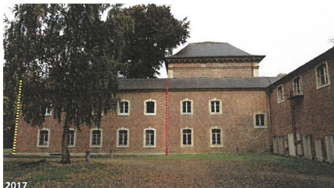
Photo de l'aile perpendiculaire Ouest – APW : La partie à gauche de trait rouge date de la fin des années 1970. A droite, il s'agit d'une partie du volume qui assurait à l'origine la connexion entre la grande dîmière et l'aile courbe Ouest. Ce volume d'origine et son extension de 1970 seront démolis.
