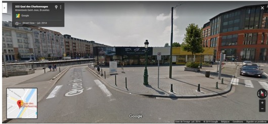
Vue de l'entrepôt avant l'incendie, depuis la place Saintelette, © Google maps
