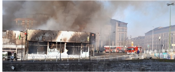
Incendie en février 2018
