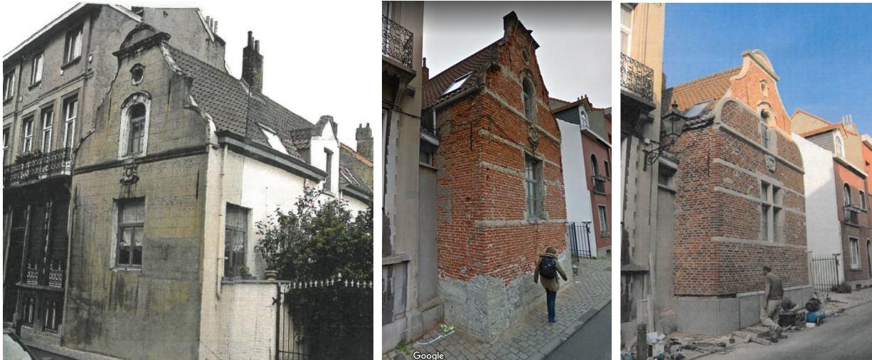
De gauche à droite : état vers 2000 avant la restauration, après décapage en 2017 et après la restauration des briques, lors de la pose de la plinthe en pierre bleue © CRMS, Streetview et Urban.brussels.
