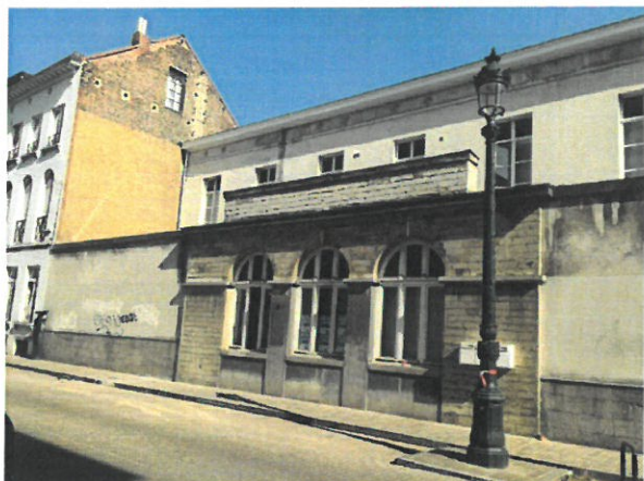
Façade à rue du pavillon 4 © Urban.brussels
