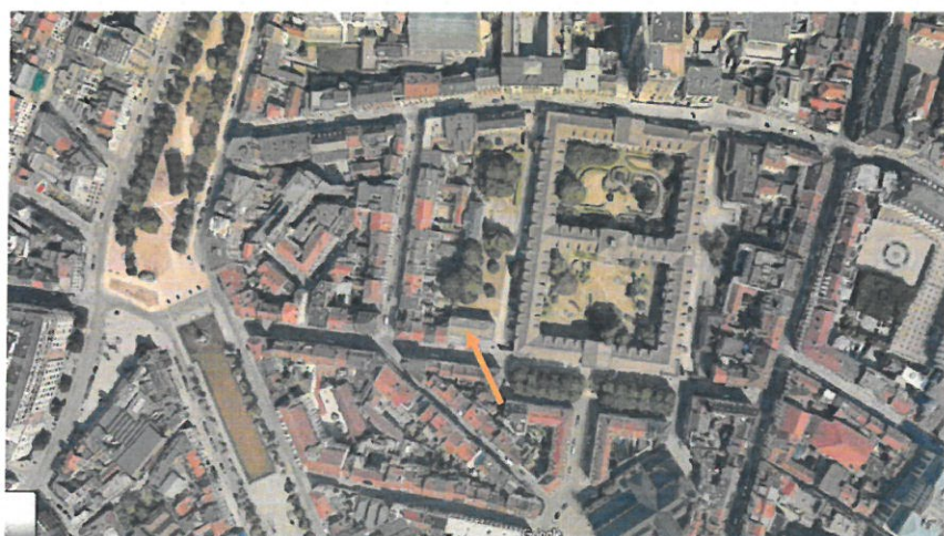
Double quadrilatère de l'ancien Grand Hospice, avec l'indication du pavillon 4 © Google Maps
