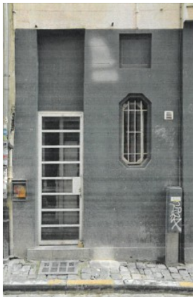
Porte latérale – état actuel
