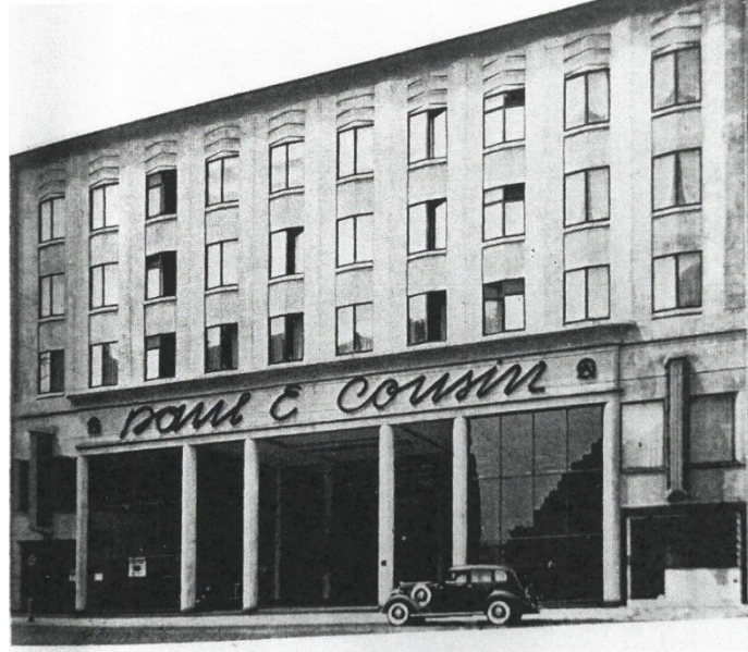
Fig. 1. Vue du showroom et de sa rehausse. Cliché issu de la revue "Publica" édition d'architecture et d'industrie, 1936, p. 29.
