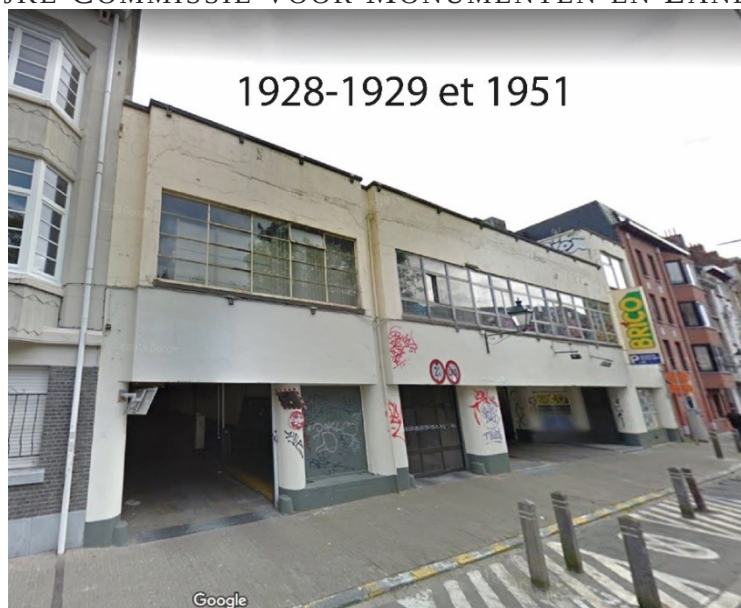
Fig. 2. Bâtiment côté rue Moris. Datation sur une photographie © Google Maps.
