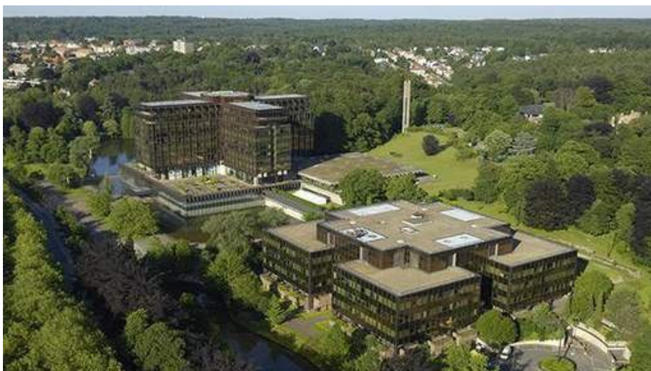
À l'avant-plan, l'annexe vouée à la démolition © extrait du dossier
