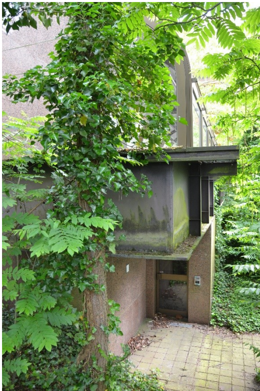
Noyau de support et de liaison de la passerelle inséré dans la végétation, 2019 © BUP-CRMS
