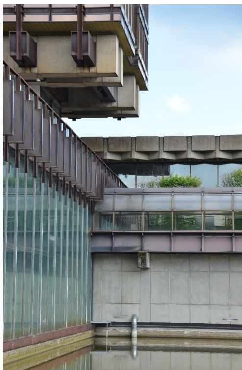
L'articulation entre la passerelle et l'ancienne Royale Belge, 2019 © BUP-CRMS
