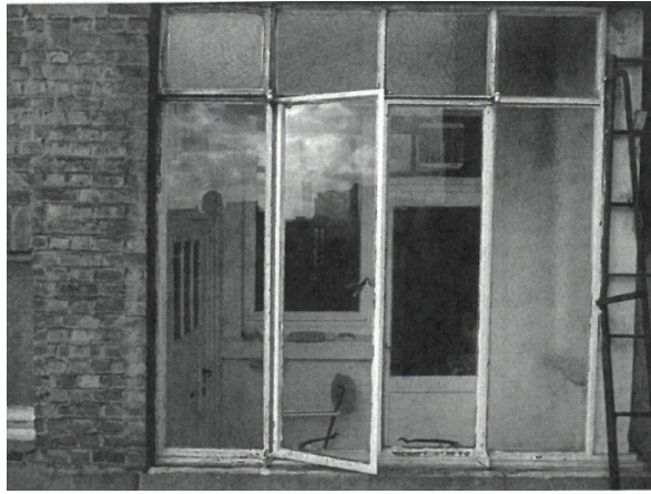
Fig.2. Photo d'un des châssis métalliques originaux. Fe.2.4CD.D, appartement 2.4C - type FFFF 20.19. Illustration issue du projet de PGP, planche 6.A3/13.3b.
