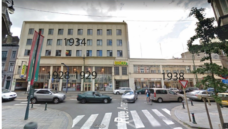
Fig. 3. Bâtiments côté chaussée de Charleroi. Datations sur une photographie © Google Maps.
