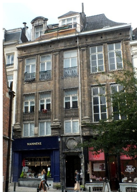
Fig. 1. Vue des nos 31 et 29 rue de la Madeleine. © CRMS, 2019.
