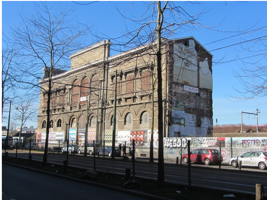
Façades Nord et Est, 2014 © urban.brussels
