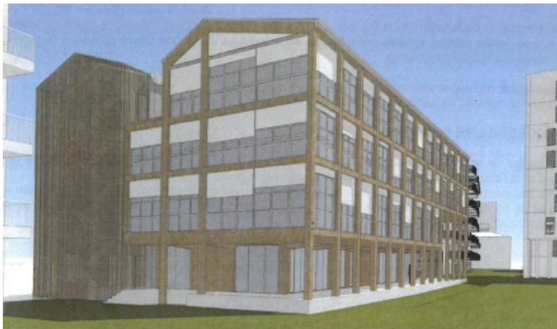
Escalier de secours derrière le bardage en bois ajouré (à gauche), extrait du dossier 2018 © Art & Build
