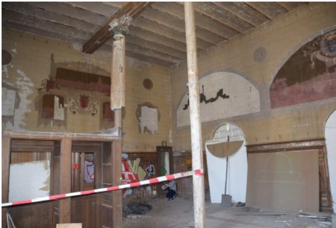
- Pièce centrale, situation en 2018, extrait du dossier 2018 © Art & Build
