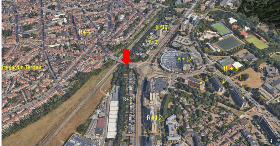
Vue aérienne et nombre de niveaux des constructions environnantes © Urban.brussels
