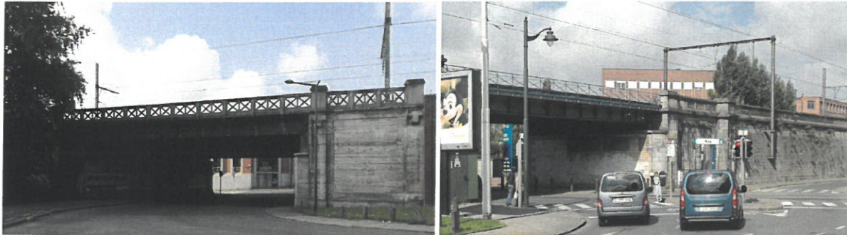
Vue du côté de Bruxelles sur les ponts Nens (gauche) et chaussée de Mons (droite) © Urban.brussels
