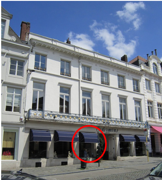
Fig. 3. Localisation de la travée concernée par la demande. Photo de 2015 © urban.brussels.
