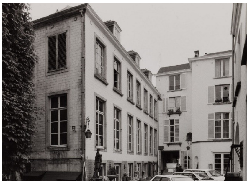
Fig. 2. Vue de la cour intérieure. Photo de 1989 extraite du site irismonument.be .
