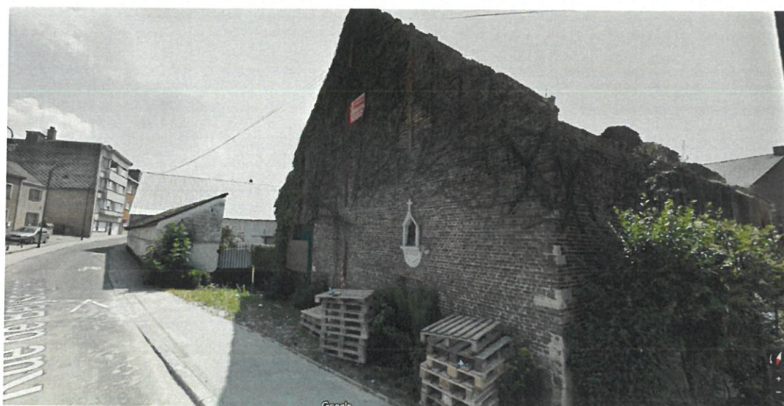
Vue de la grange, de l'entrée et de la porcherie (©Google maps, vue de 2013)
