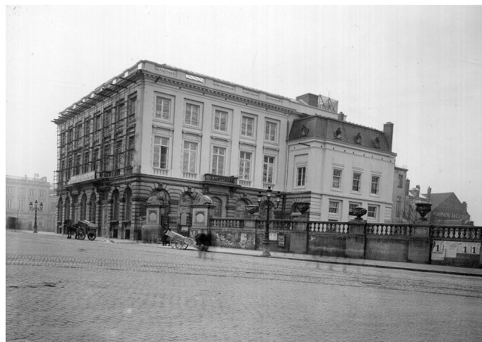
Etat 1920 avec toiture mansardée
