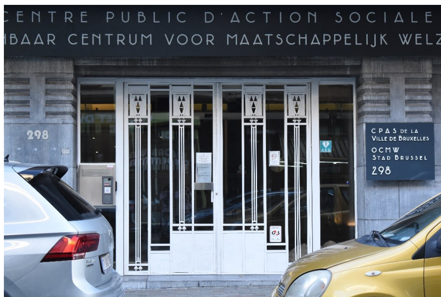
Fig. 3. Porte d'entrée en ferronnerie du bâtiment administratif. © urban.brussels, 2020.
