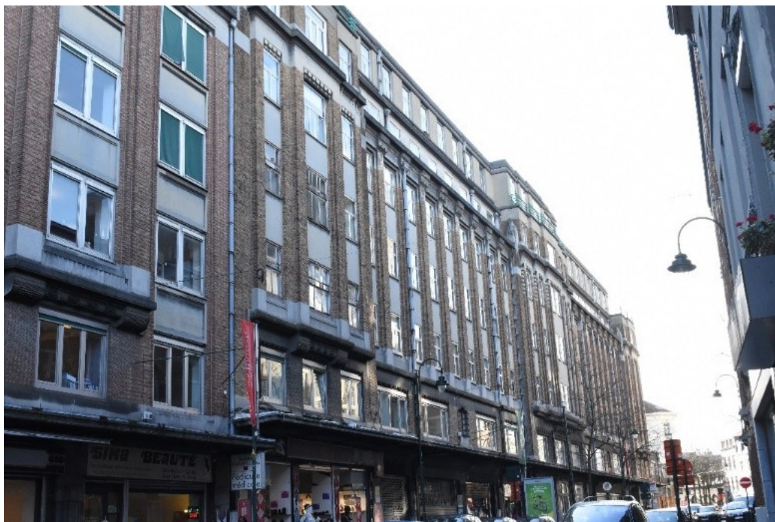
Fig. 1. Ancienne Maison des Infirmières sise rue Haute. © urban.brussels, 2020.
