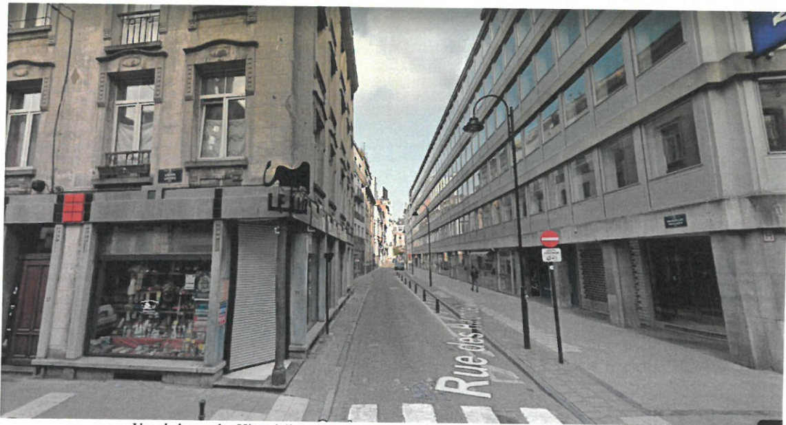
Vue de la rue des Hironnelles, depuis l'angle Laeken/Hironnelles (©Google maps, 2018)
