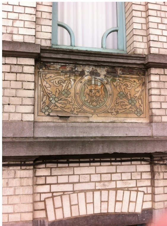
Détail d'un sgraffite (©Atelier d'Architecture du Congrès)
