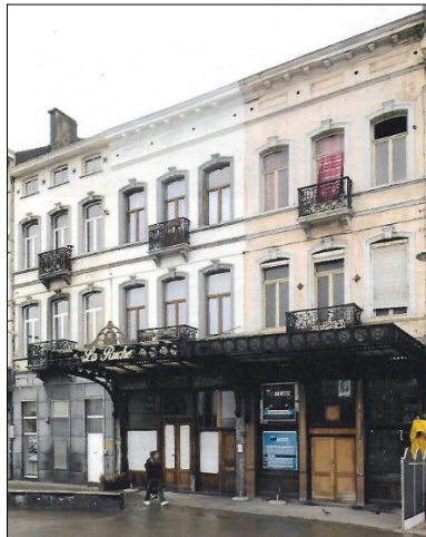
Fig. 1. Boulevard Jamar, 1a à 1c, façades à rue.
