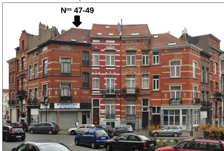
Fig. 1. Vue sur les bâtiments n os 41 à 55 place Colignon. © urban.brussels, 2014.
