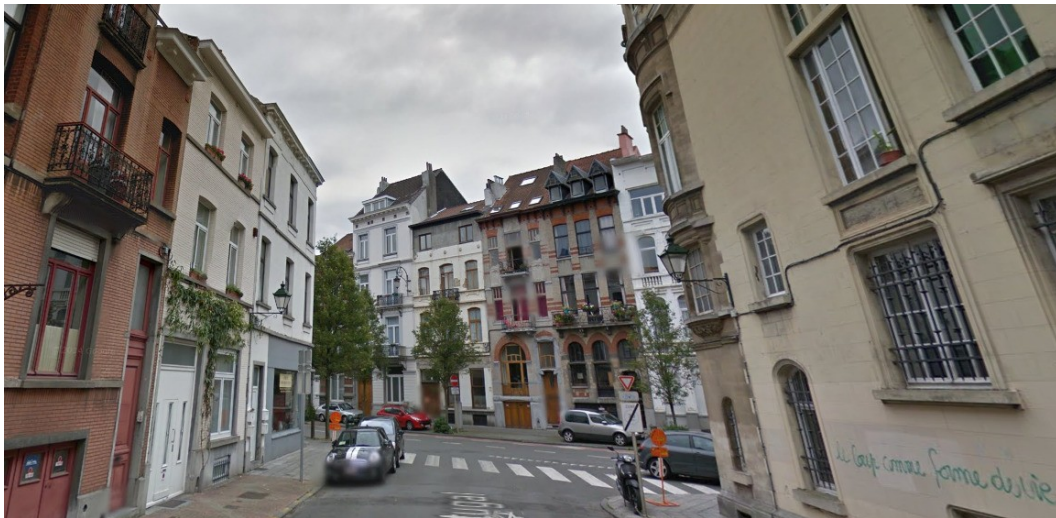
Vue depuis la rue du Portugal (©Google maps, 2014)
