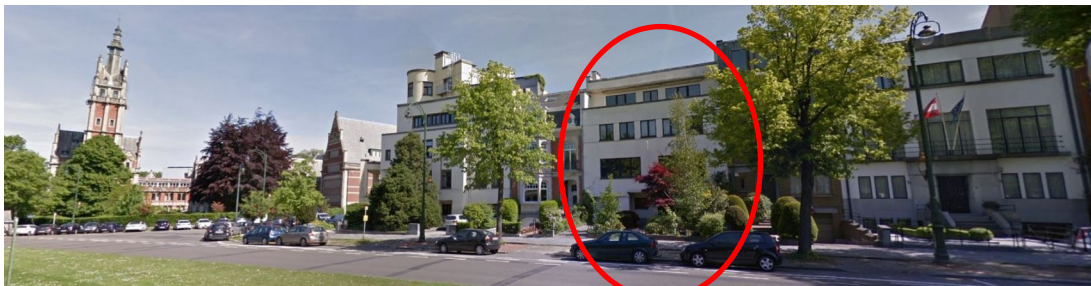
Façade avant travaux © Google maps
