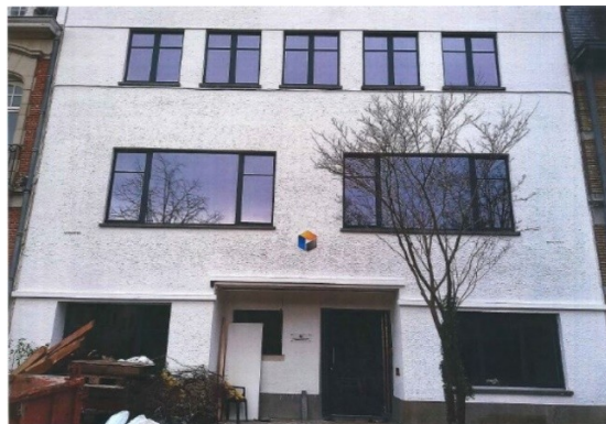
Façade après travaux, © CRMS, février 2019
