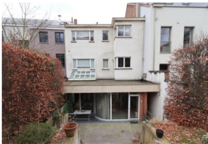
Photo 6 - Photo de la façade arrière vers le n° 13
