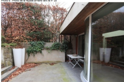
Situation actuelle à régulariser
