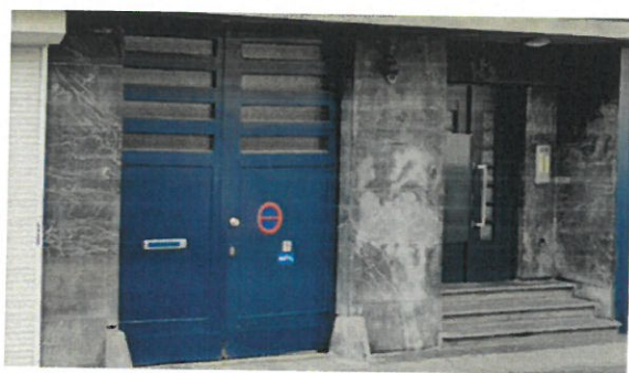
Detail gevelbekleding Belgisch Blauw van Bioul in de L. Crickxstraat (links) en de Zelfbestuurstraat (rechts)
