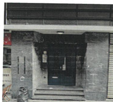
Detail gevelbekleding Belgisch Blauw van Bioul in de L. Crickxstraat (links) en de Zelfbestuurstraat (rechts)
