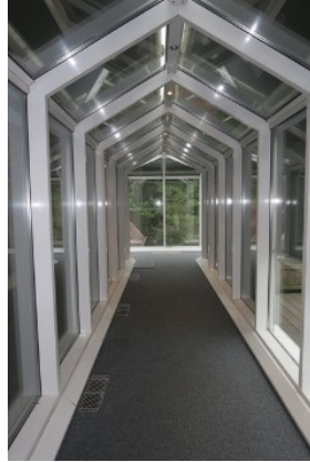
Vues de l'arrière et de l'intérieur de l'annexe (transformation début des années 1990) – photos CRMS
