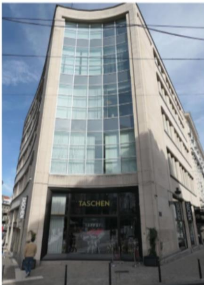
Façade vitrée tournée vers la place du Grand Sablon (1962)
