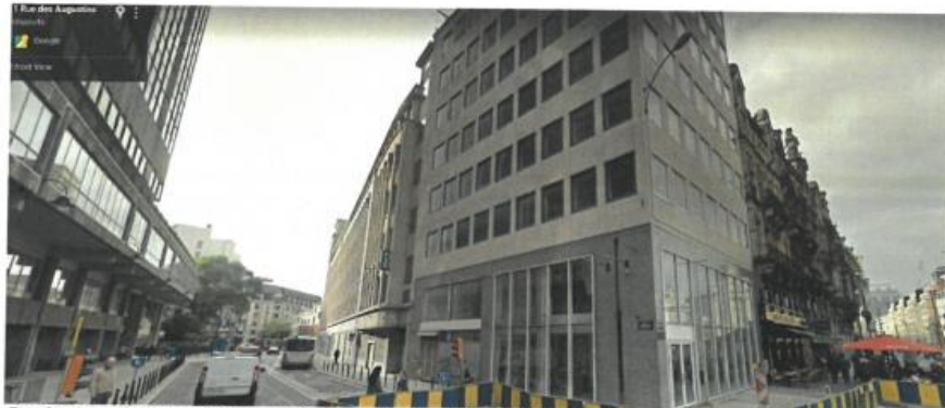
Rue des Augustins, hormis le bâtiment d'angle avec la place, belle enfilade prolongeant l'immeuble rue de Laeken, 35 (©Google maps, 2018)
