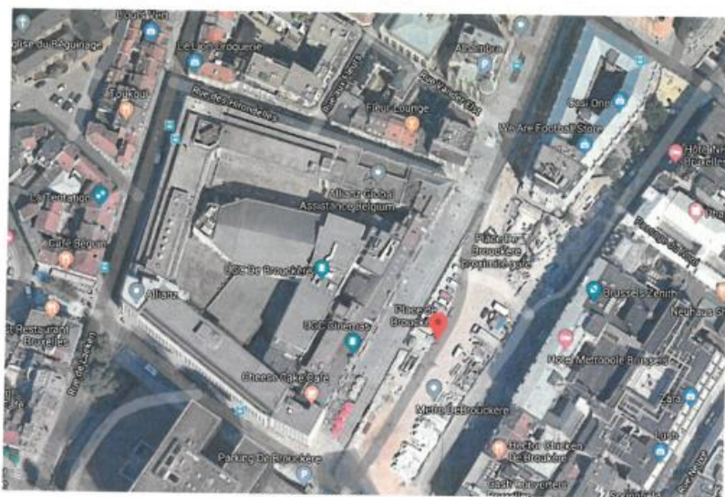
Vue de l'îlot (©Google maps, 2020)
