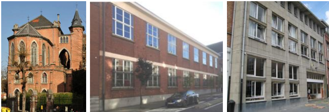
Vues de la chapelle, de l'aile Primaire D et de l'aile primaires B (extr. du schéma directeur)
