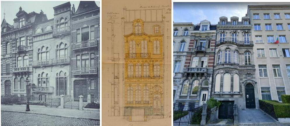
Ci-dessus, de droite à gauche : photo de la façade de style mauresque de 1896, plan de l'architecte pour la transformation de la façade en 1913 (source : www.monument.heritage.brussels ), vue de l'immeuble en 2020 (source : ©Google Street View)
