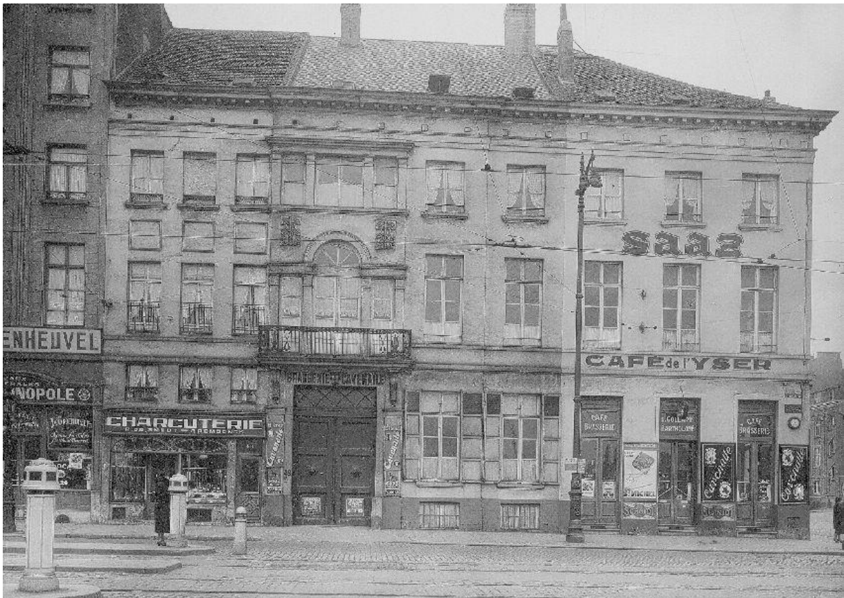
Vue du boulevard d'Anvers, 48 à 50, avec – à gauche- une portion de la maison n°46-47 (©KIK-IRPA, Brussels (Belgium) – cliché A105426), non daté
